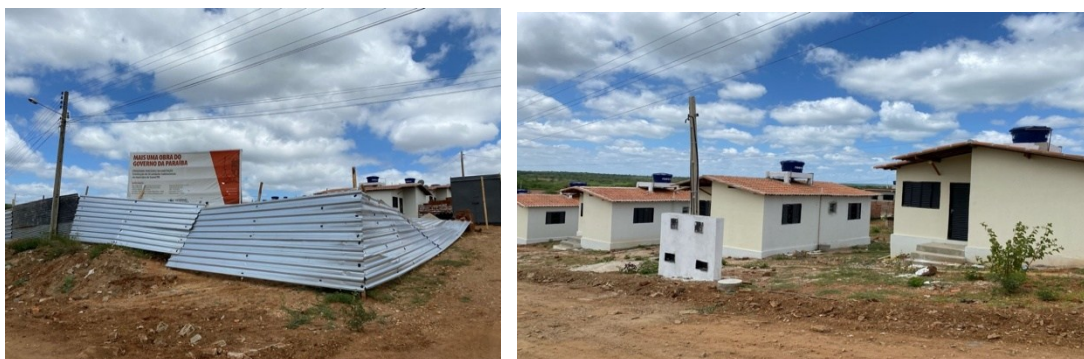
Figuras 3 e 4 - Construções em andamento das casas populares em Sumé-PB
