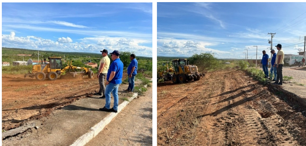
Figuras 1 e 2 – Limpeza de terrenos para a construção das casas populares.
