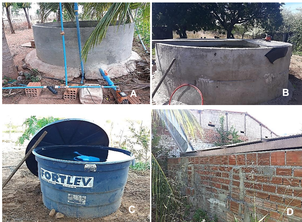
Figura 3. Armazenamento de água. A e B. Caixa d' água de concreto; C. Caixa de polietileno; D. Cisterna de placa. Fonte: arquivo da pesquisa.
