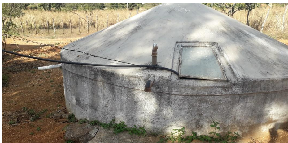
Figura 3: Bomba elétrica retirando água da cisterna.
