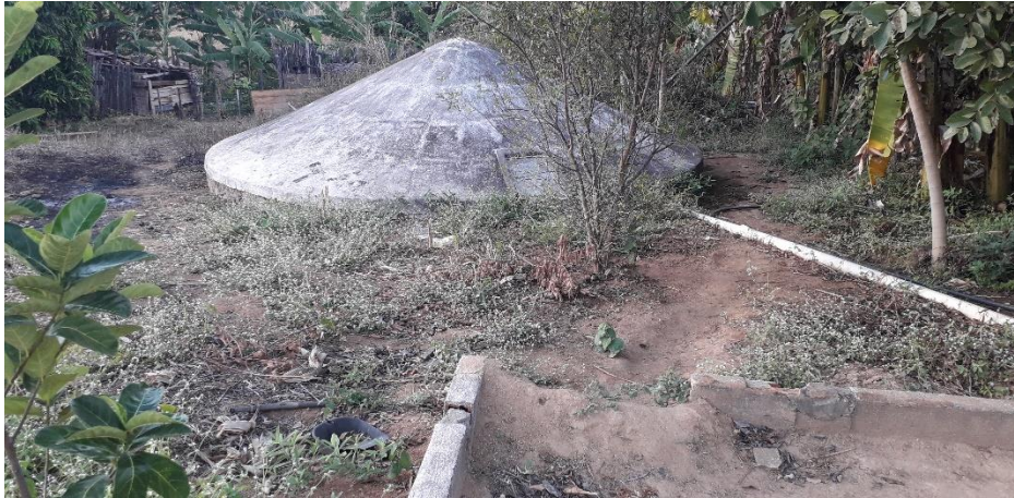
Figura 6: Cisterna de calçadão. Fonte: Próprio autor, (2019)
