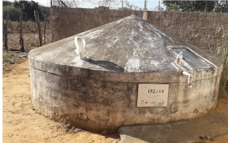
Figura 2: Cisterna de placa.
