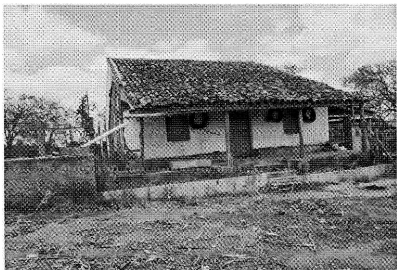
A CASA GRANDE, HOJE COM MAIS DE 200 ANOS DE CONSTRUÍDA. PARTE JÁ DEMOLIDA PELA A AÇÃO DO TEMPO.
