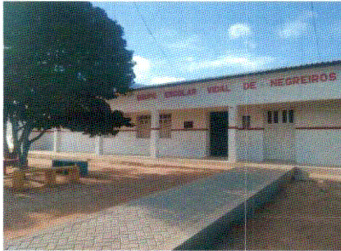
Figura 1: Fachada da escola
