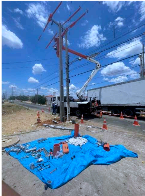
Figura 13 – Substituição de poste com auxílio da equipe de Linha Viva (LV)
