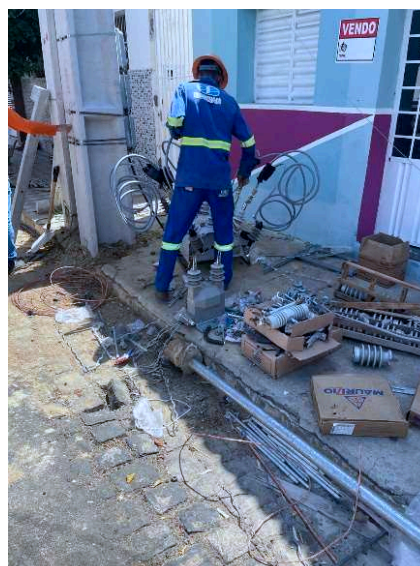
Figura 15 – Colaborador fazendo a montagem de um religador automático
