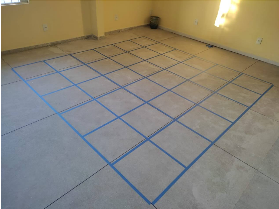
Figura 12 – Malha 3 m por 3 m construída para execução do experimento.
