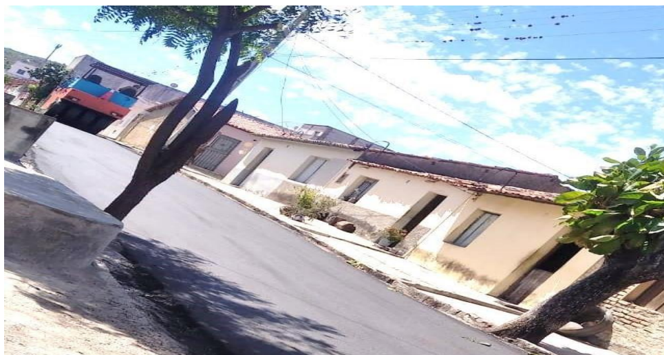
FIGURA 11: Trabalho da malha asfáltica- Rua Mãe Santa
