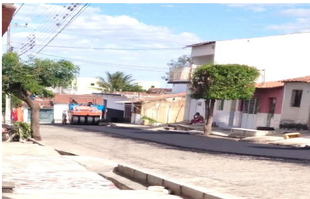
FIGURA 10: Trabalho da malha asfáltica- Rua Teotônio Martins
