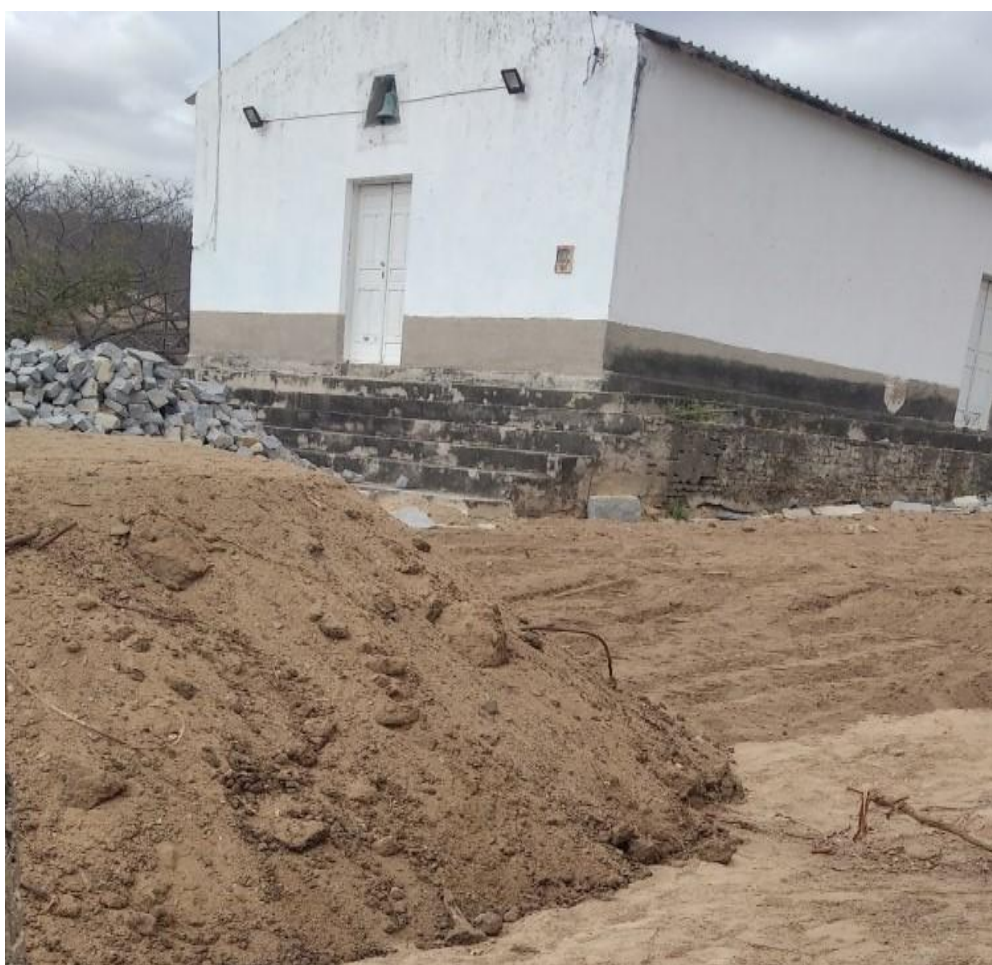
FIGURA 05: Pavimentação de Santa fé– igreja ao fundo
