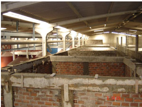
Fig.5 – Concretagem final de pilares e vigas dos silos..
