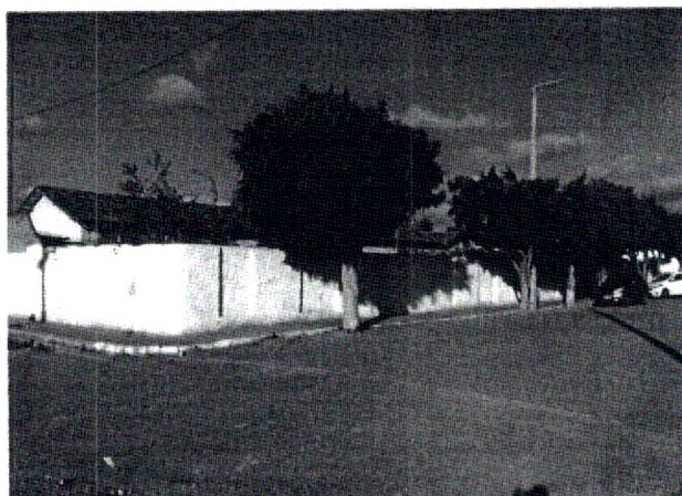
FIGURA 2: LATERAL DA ESCOLA
