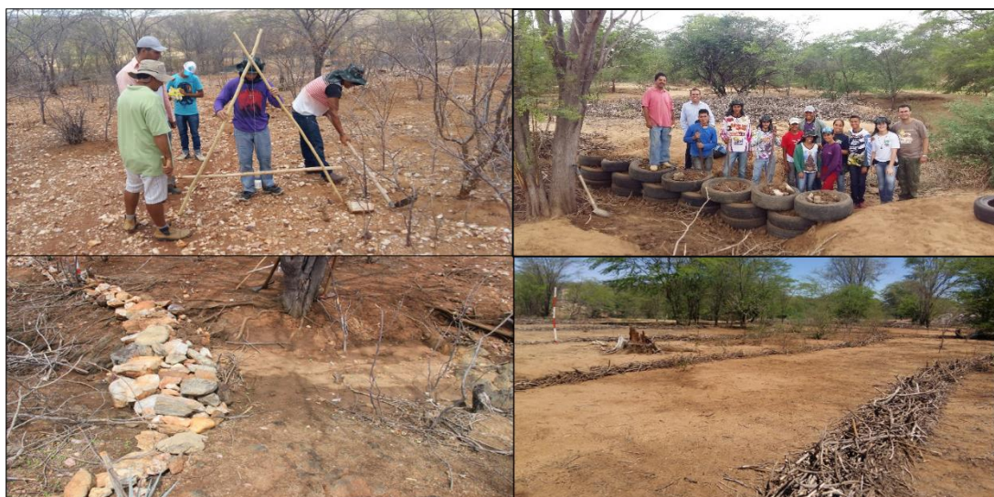
Figura 16. Utilização do pé-de-galinha e produção dos cordões de contorno.
