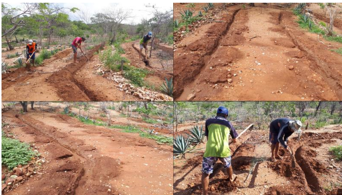
Figura 21. Abertura de Sucos de Captação de Água.
