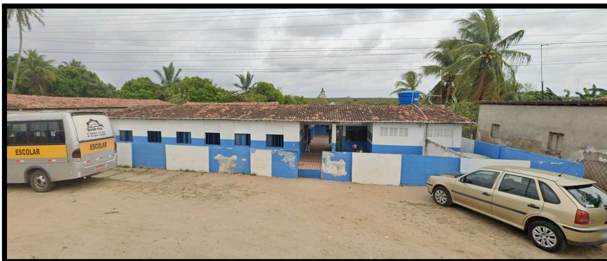
Figura 11 - Fachada da Escola Municipal José Mesquita (EMJM)
