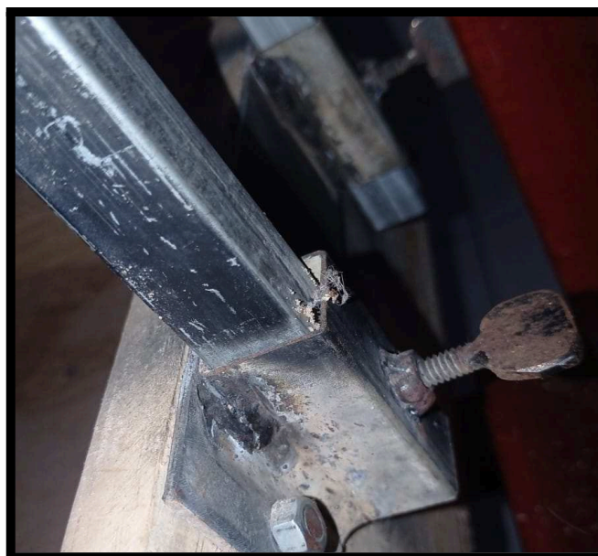
Figura 22 - Base da estrutura fixada na caixa de madeira
