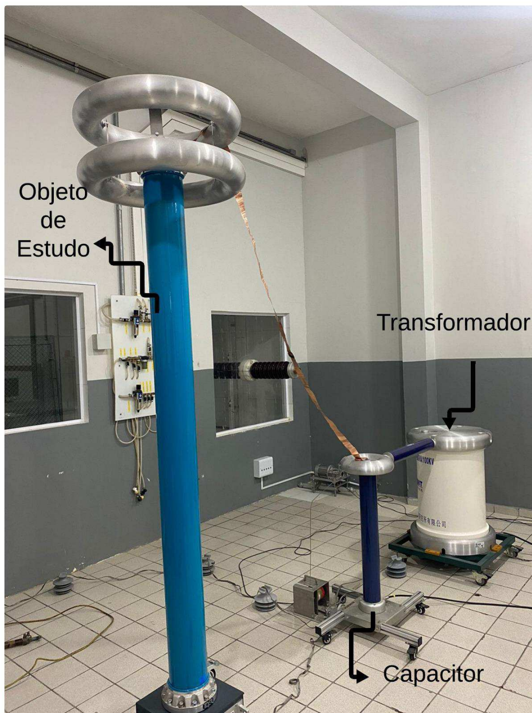
Figura 10 – Montagem Real do Ensaio de Tensão Alternada.
