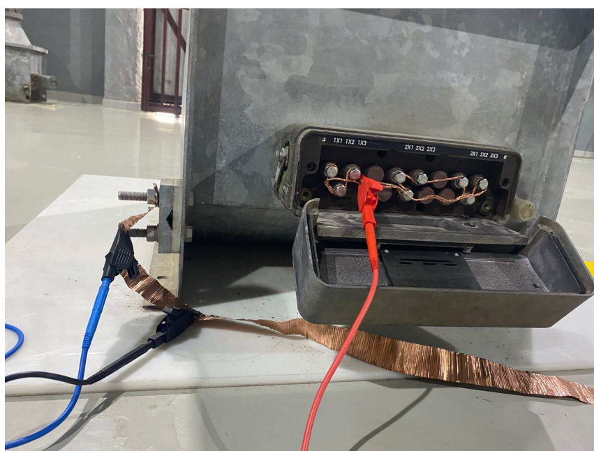
Figura 40 – Ensaio da Isolação entre os Enrolamentos do Secundário e a Carcaça.
