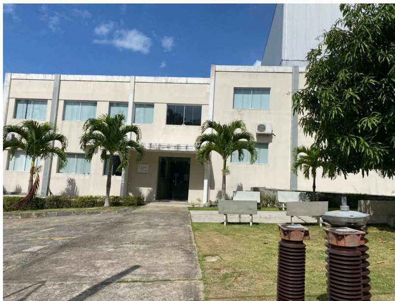
Figura 1 – Fachada do LAT.
