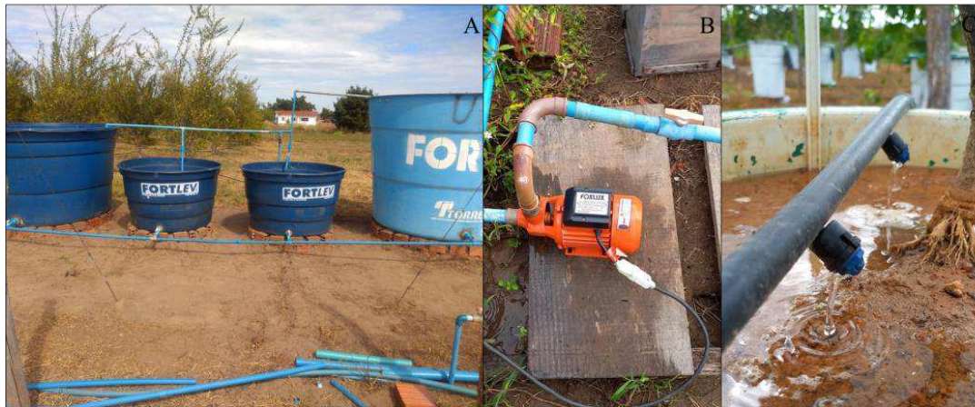
Figura 4. Detalhes do sistema de irrigação: instalação das tubulações (A), conjunto motobomba (B) e gotejadores (C)
