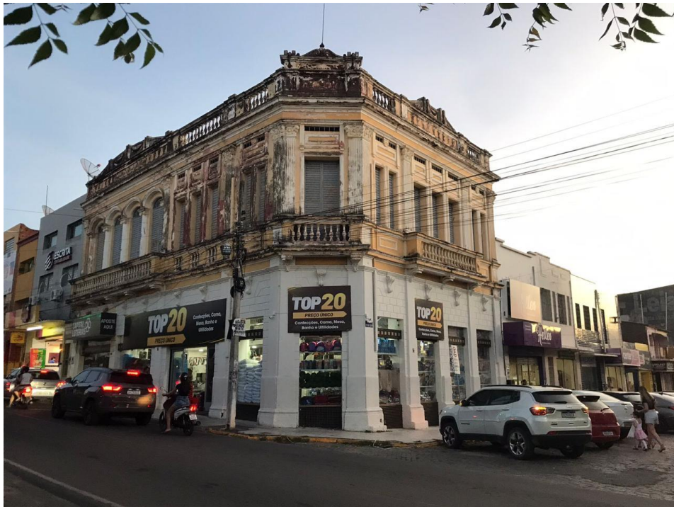
Imagem 08 - Foto arquivo pessoal. Prédio da antiga Casa Ypiranga com forma e estrutura parcialmente preservada.
