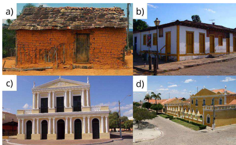
Figura 03: a) Casa de Pau-a-pique b) Casa de alvenaria com tijolo de adobe. c) Teatro Ribeira dos Icó's Icó - ce. d) Casa de Câmara e Cadeia Icó-ce.
