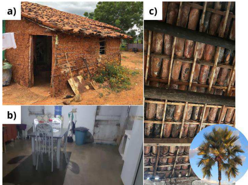
Figura 05: A) Casa de Taipa no Distrito Lavrense de Mangabeira. B) Piso de cimento queimado em casa do distrito de Mangabeira. C) Linhas de Carnaúba em telhado da antiga clínica dos Ferrér.
