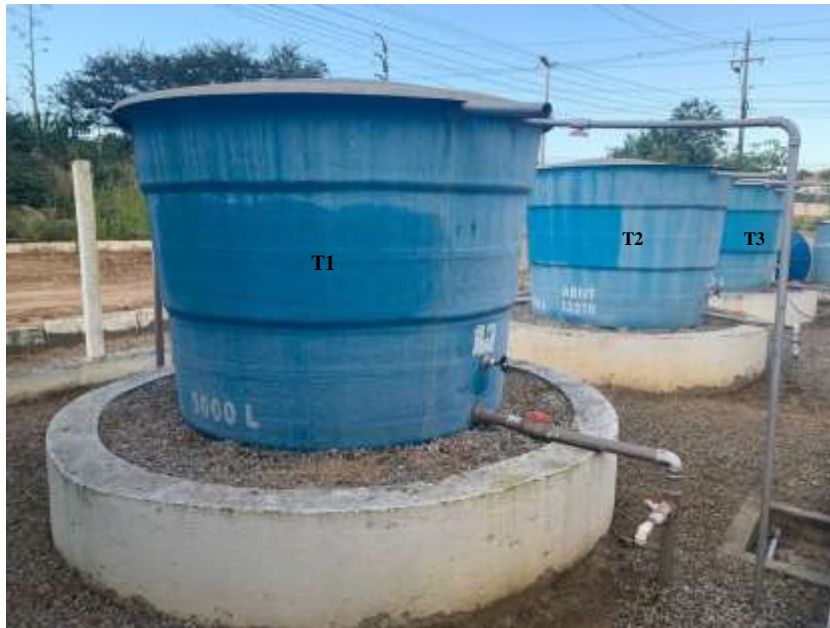
Figura 04. Tanques de fibra de vidro de 5.000 litros do sistema de dessalinização.
