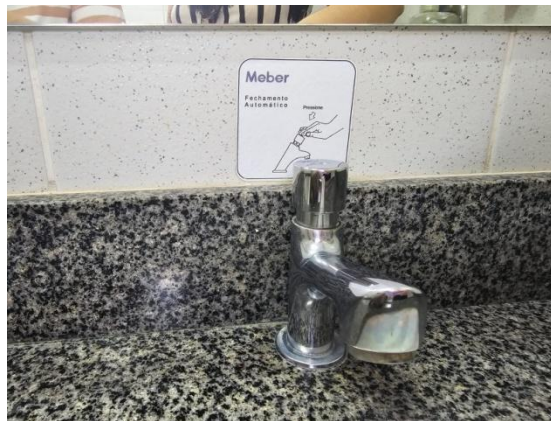
Figura 21. Torneira com temporizador
