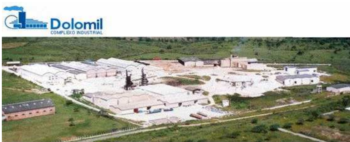
Figura 16: Complexo Industrial Tecnológico da Empresa DOLOMIL Industrial Ltda.
