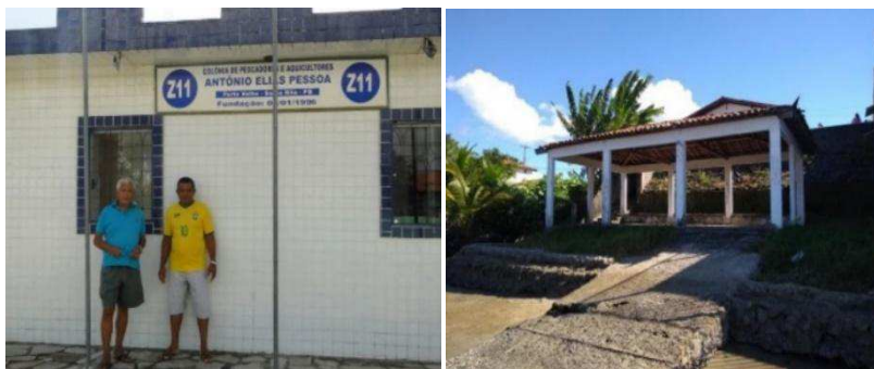
FIGURA 2 - FACHADA E ESTALEIRO COLÔNIA Z-11.
