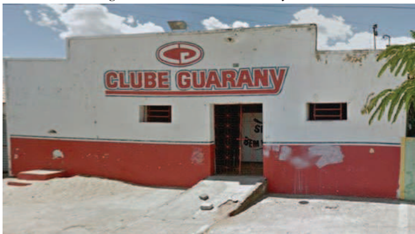
Fotografia 1: Fachada do clube Guarany em 2012.
