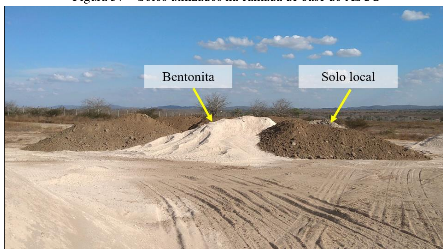
Figura 57 – Solos utilizados na camada de base do ASCG
