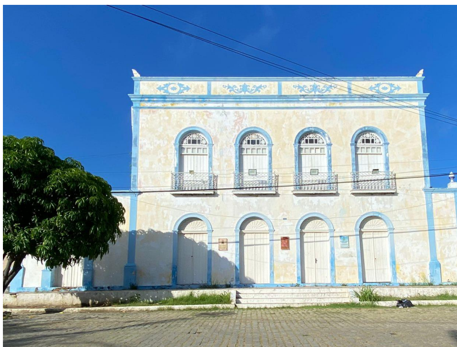
Figura 11 – Fachada do Sobrado
