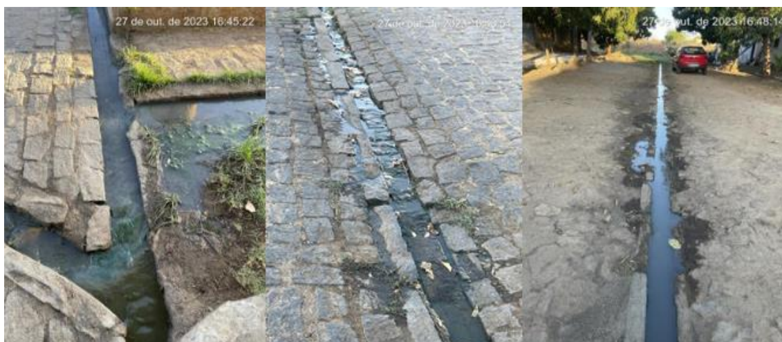
Figura 20: Esgotos a céu aberto na cidade de Ipueira-RN.
