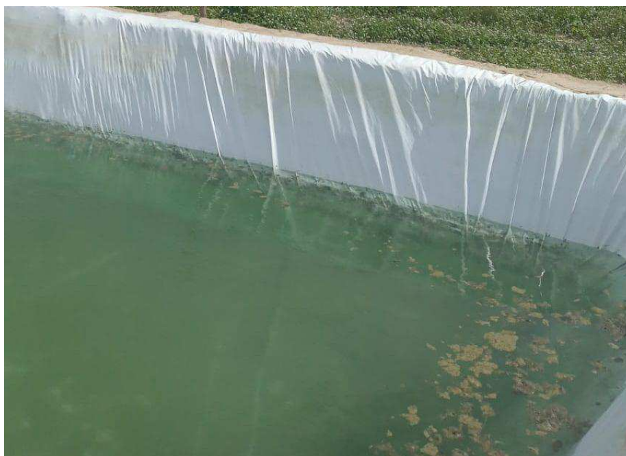
Figura 8. Reservatório de água para que serve de aporte para o sistema de irrigação.
