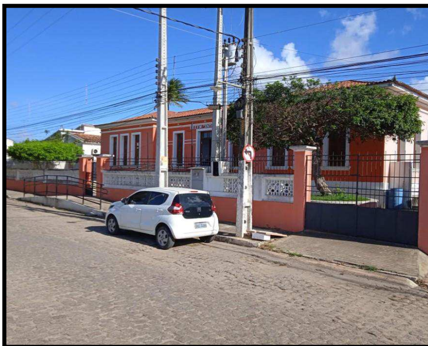
Foto 1 – Fachada da Escola E. E. F.M. Gentil Lins
