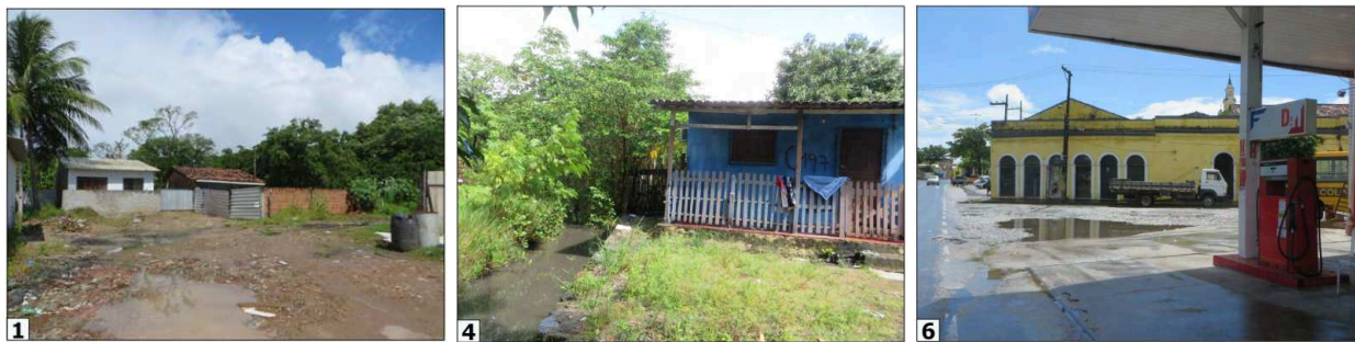
Figura 20: Cenários com empoçamentos e evidenciando a infraestrutura precária do Porto do Capim.
