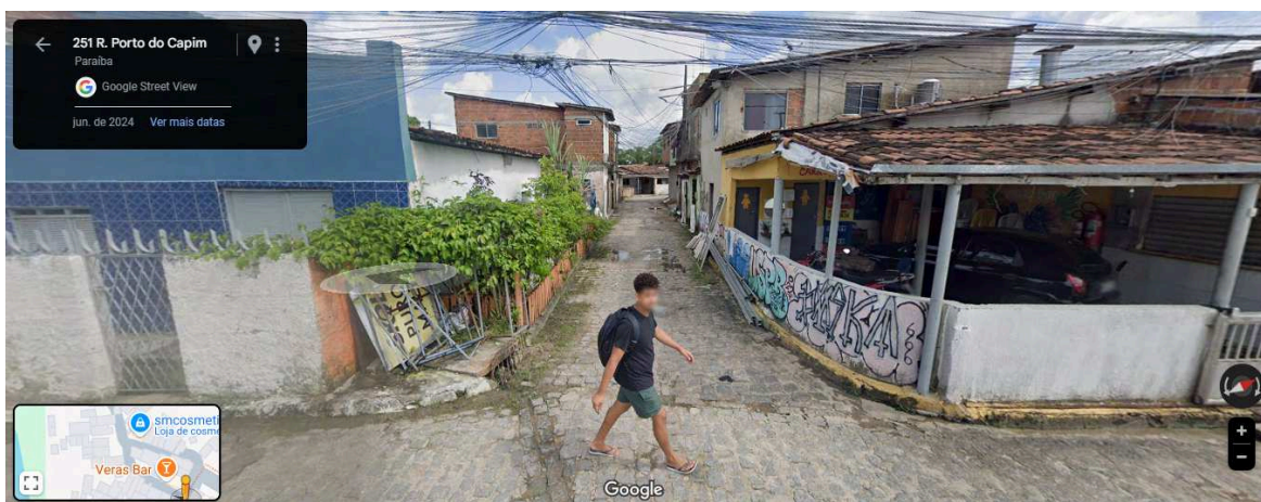
Figura 11: Rua com pavimentação irregular.
