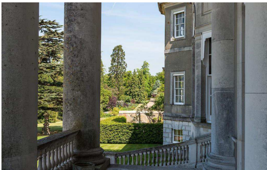
Figura 5: Fotografia de perspectiva da fachada posterior de Wrotham Park.
