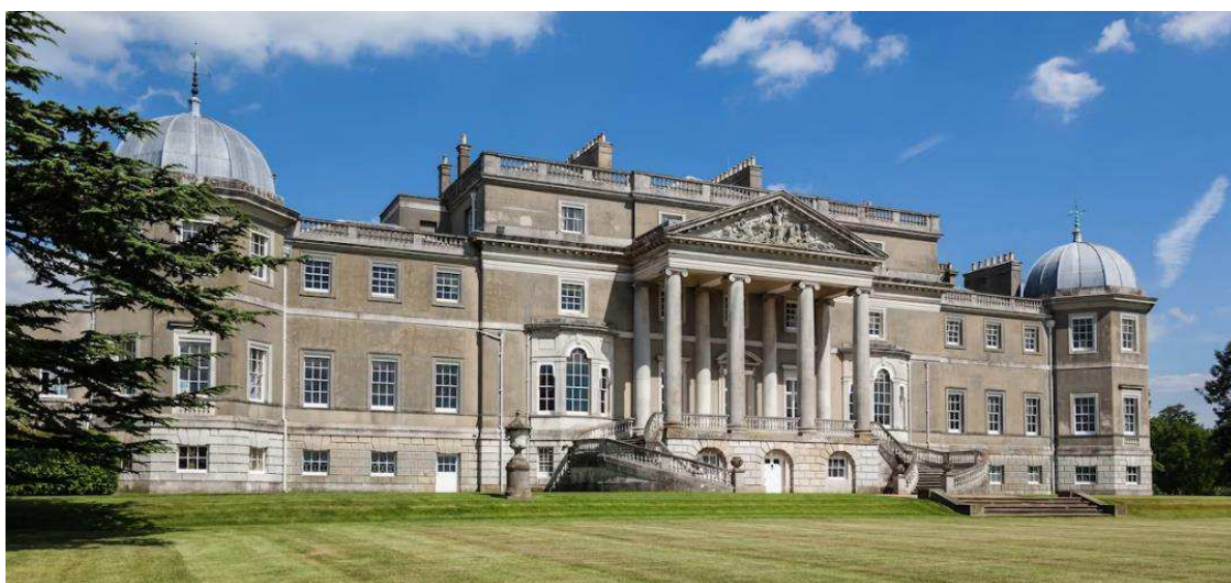
Figura 4: Fotografia da fachada posterior de Wrotham Park.
