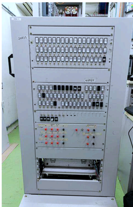
Figura 12 – Painel de Giga para os painéis do transformador
