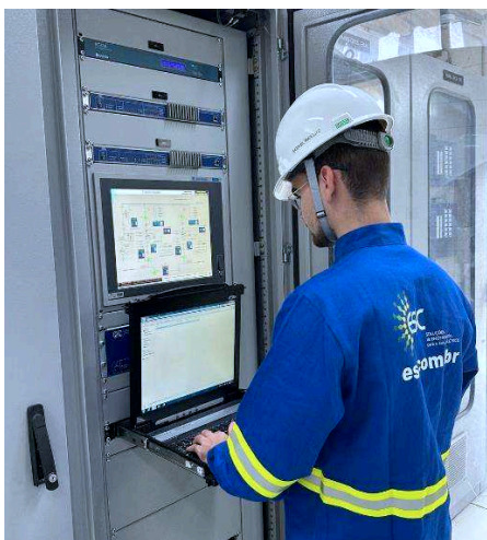
Figura 16 – Acesso à máquina de engenharia
