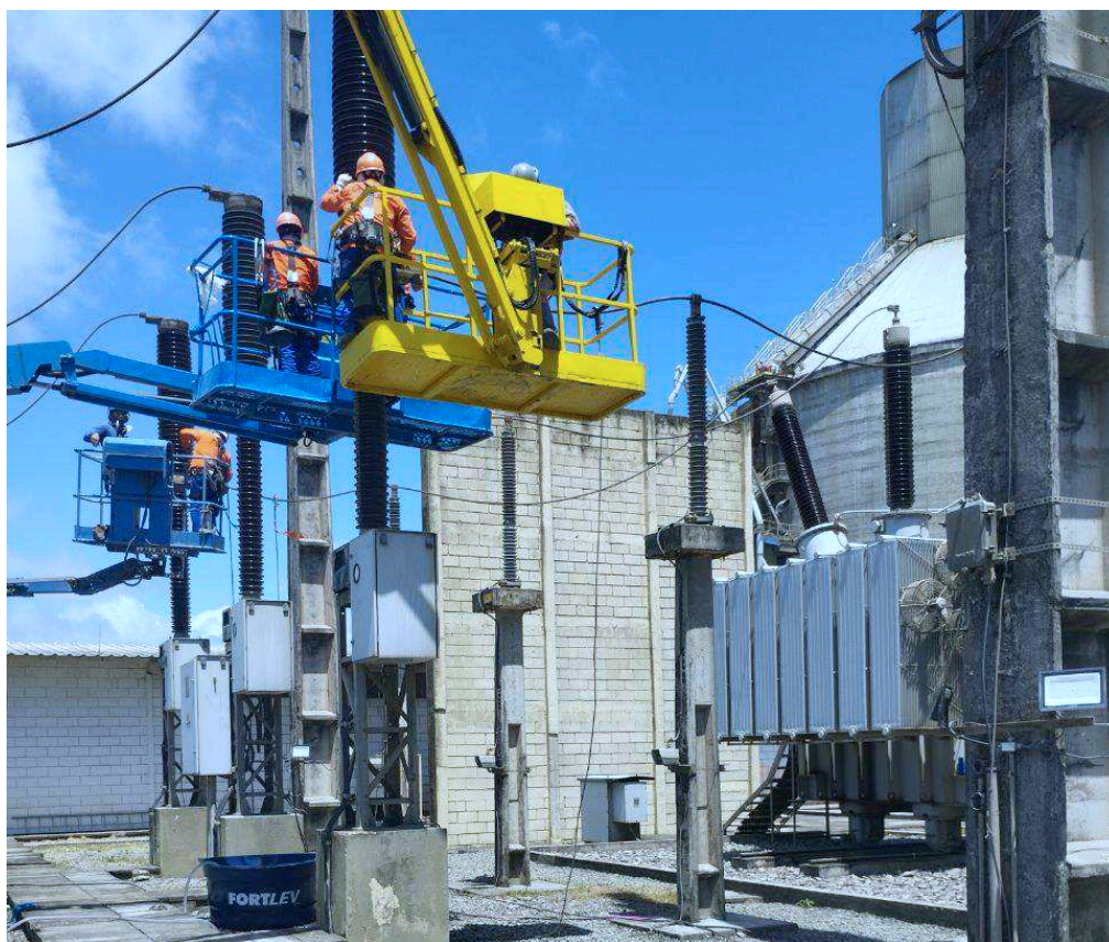
Figura 18 – Execução de limpeza em disjuntores monopolares 230kV.
