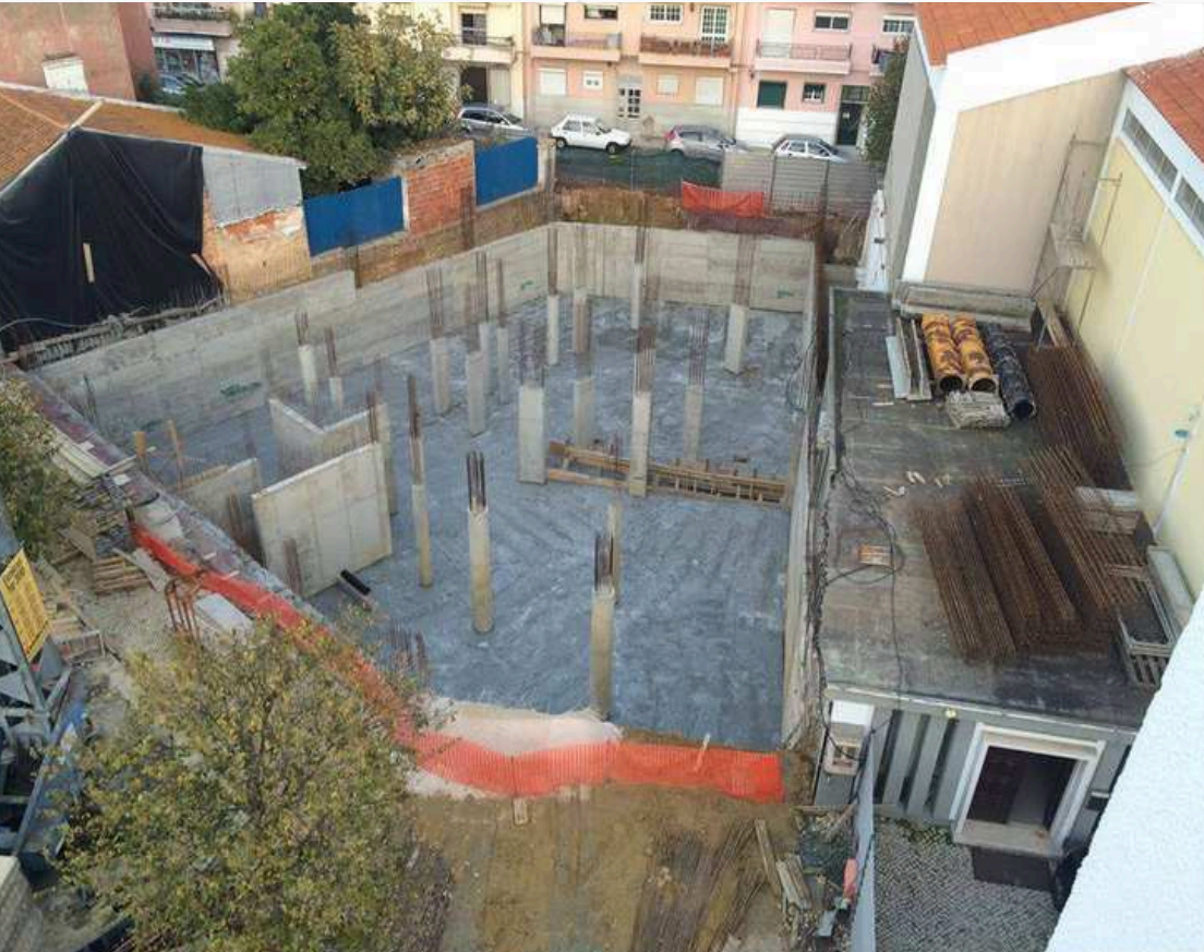
Figura 32 - Imagens da construção. Fonte: Facebook Plano Humano Arquitectos.
