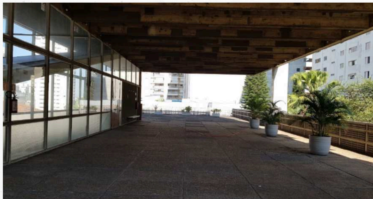
Figura 60 - Acesso a igreja. Fonte: Google Maps, 2020.
