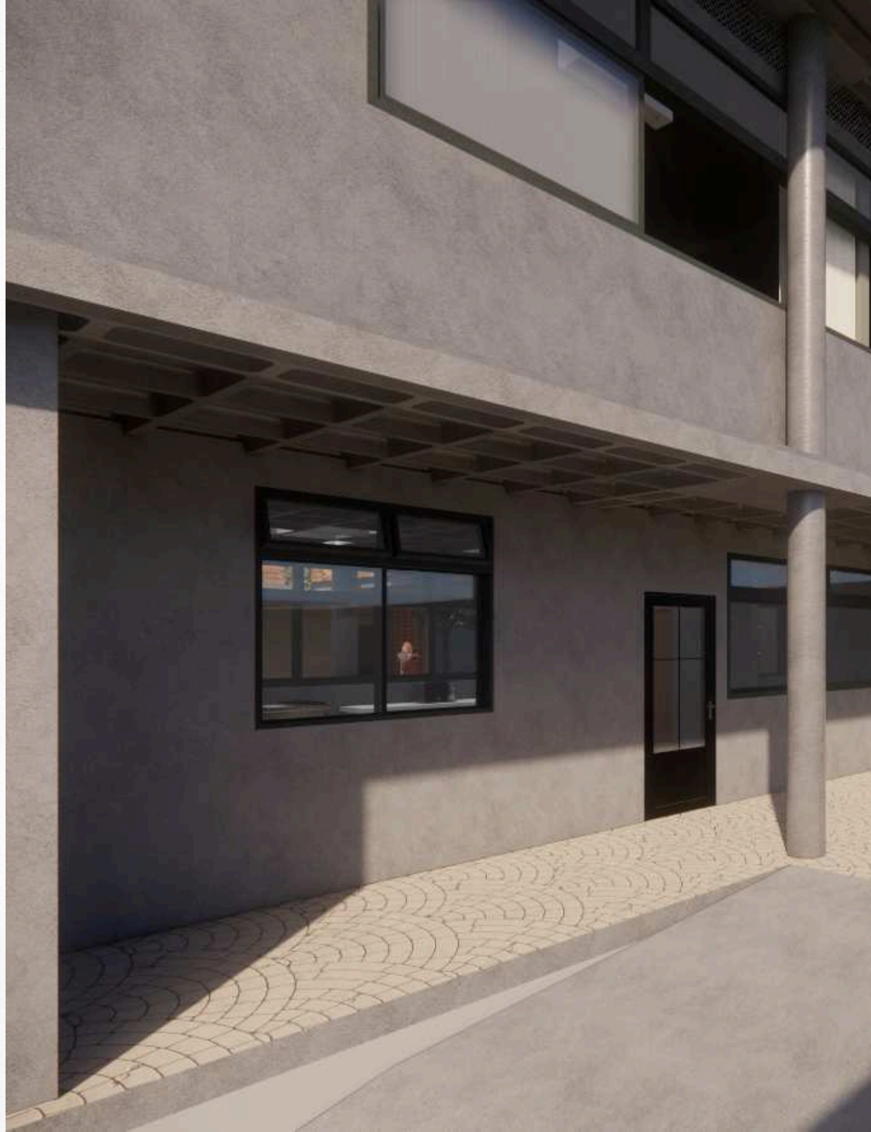
Figura 118- Laje nervurada, pilares em concreto armado.
