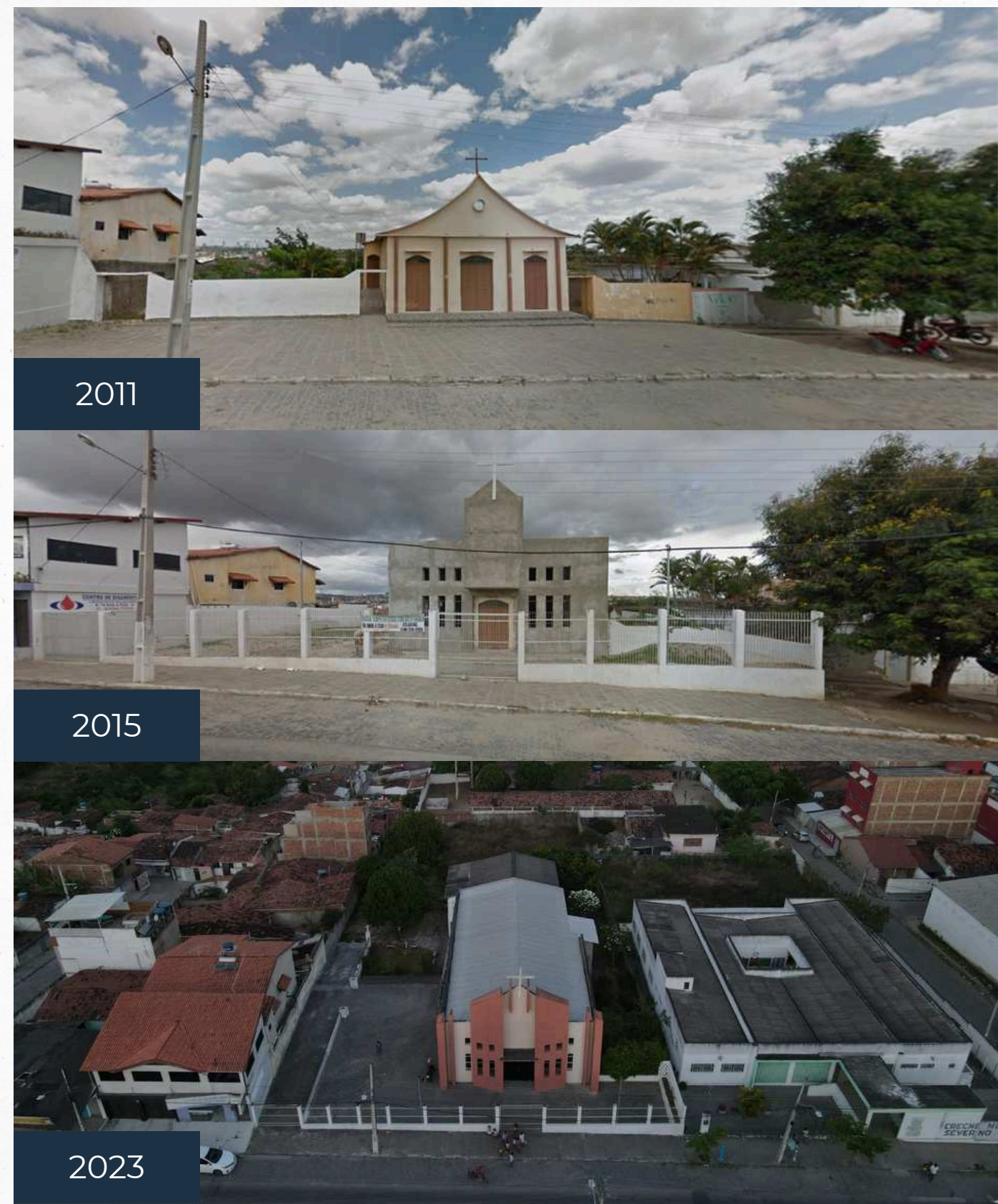
Figura 75 - Modificações na fachada da Igreja. Fonte: 2011 e 2015 - Google Maps. 2023 - Célio, Janiel.
