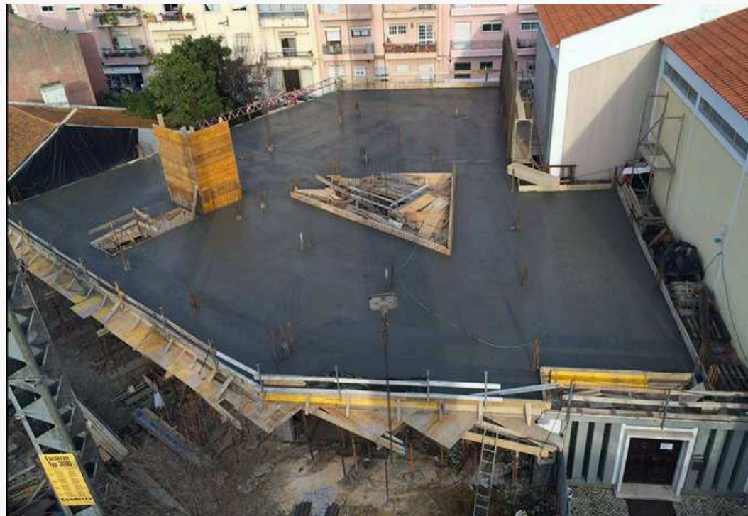
Figura 33 - Imagens da construção. Fonte: Facebook Plano Humano Arquitectos.
