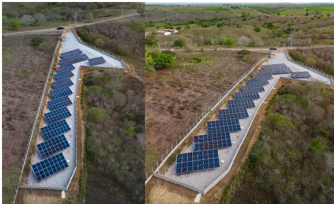
Figura 48: Imagem Aérea da Usina.
