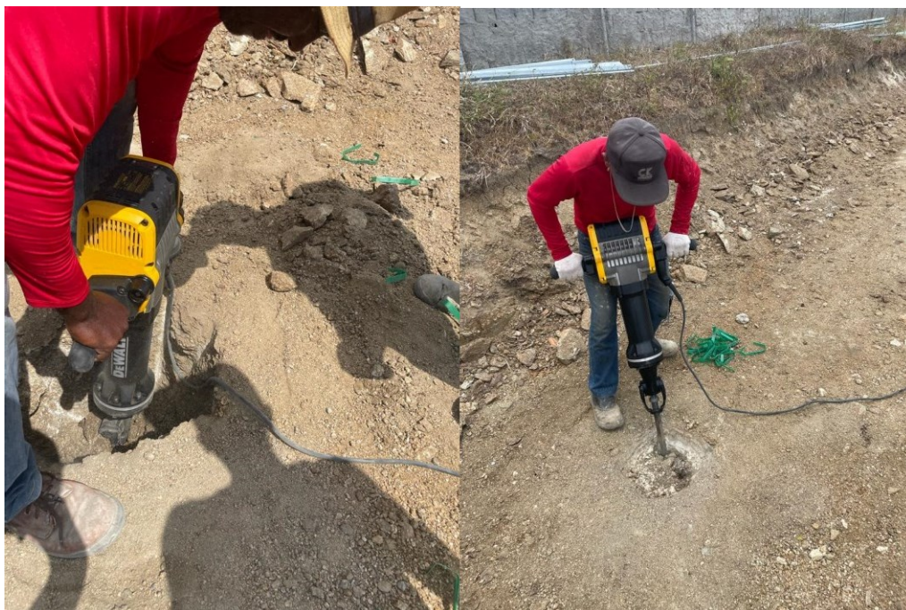
Figura 32: Preparo das Fundações.
