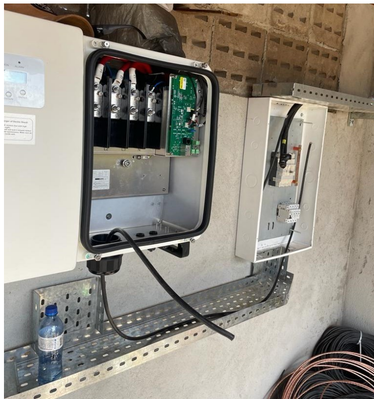
Figura 41: Fechamento dos Circuitos no Inversor.
