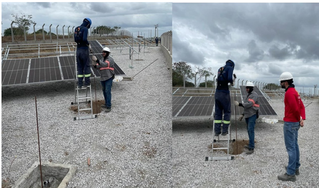
Figura 38: Alocação das Hastes de Aterramento.
