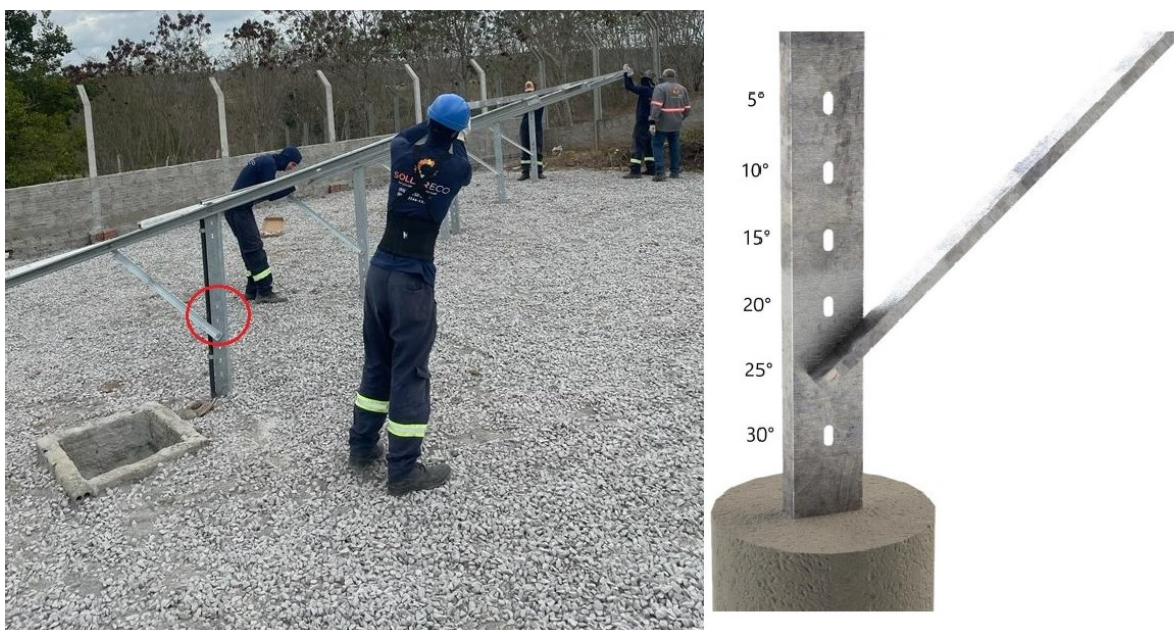
Figura 37: Inclinação de 15^\circ para as Mesas.
