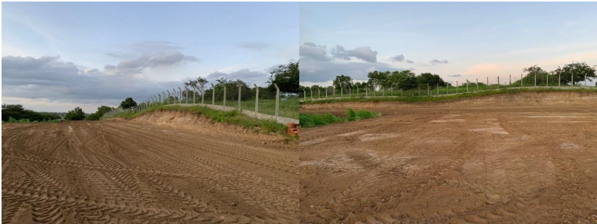
Figura 24: Terraplanagem Concluída.
