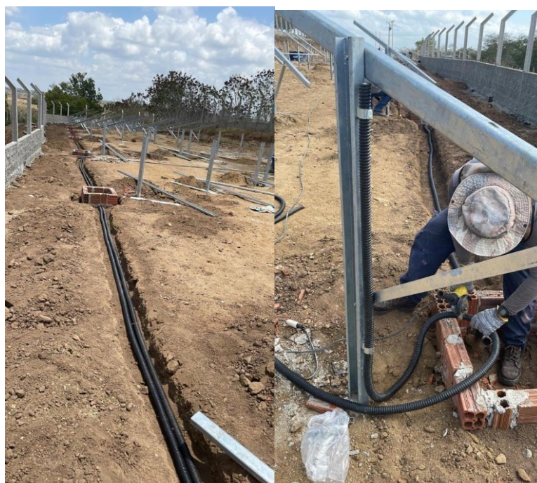
Figura 35: Passagem de Eletrodutos nas Caixas de Passagem.
