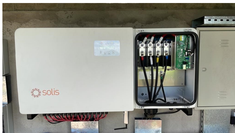
Figura 6: Caixa de Inversor Trifásico Solis 5G 380V 75 kW.
