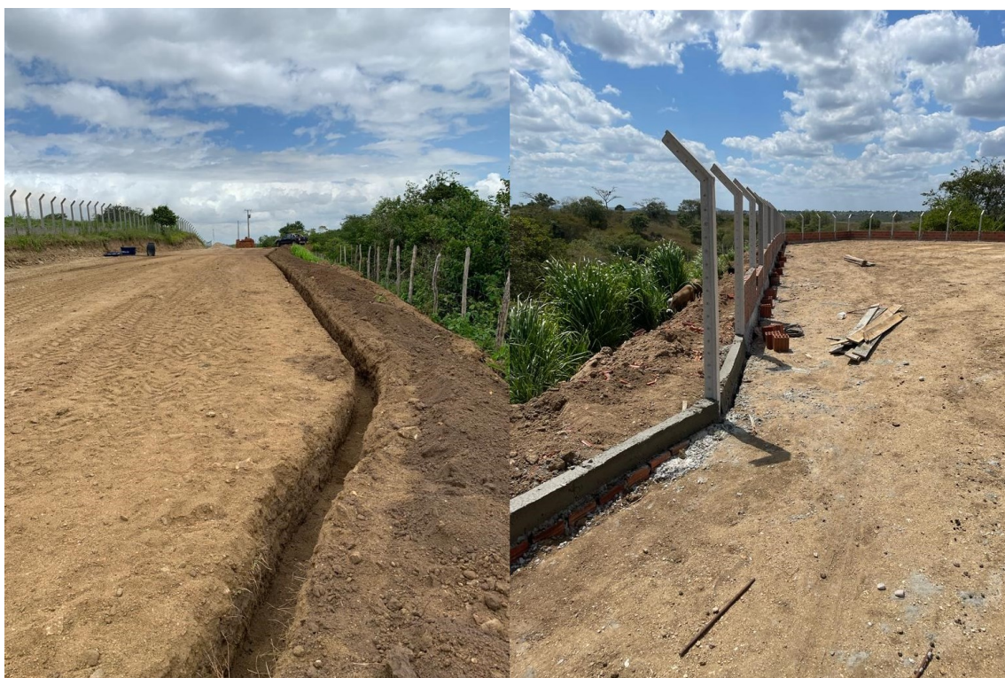
Figura 28: Preparação da Barreira de Contenção da Usina.
