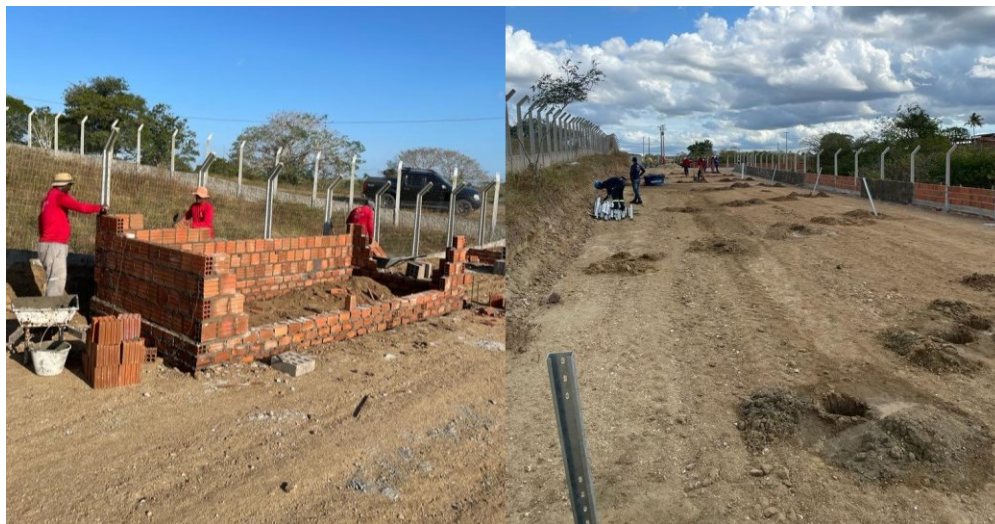
Figura 31: Construção de Abrigo do Inversor e Fundações.
