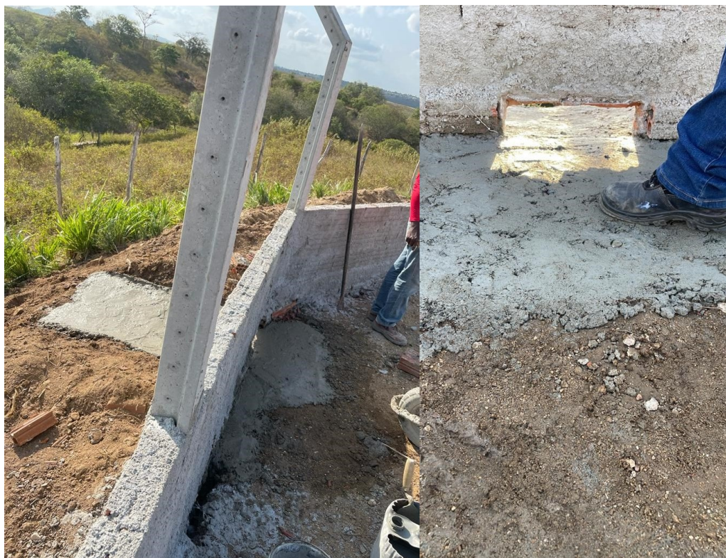
Figura 29: Pontos de Escoamento da Usina.
