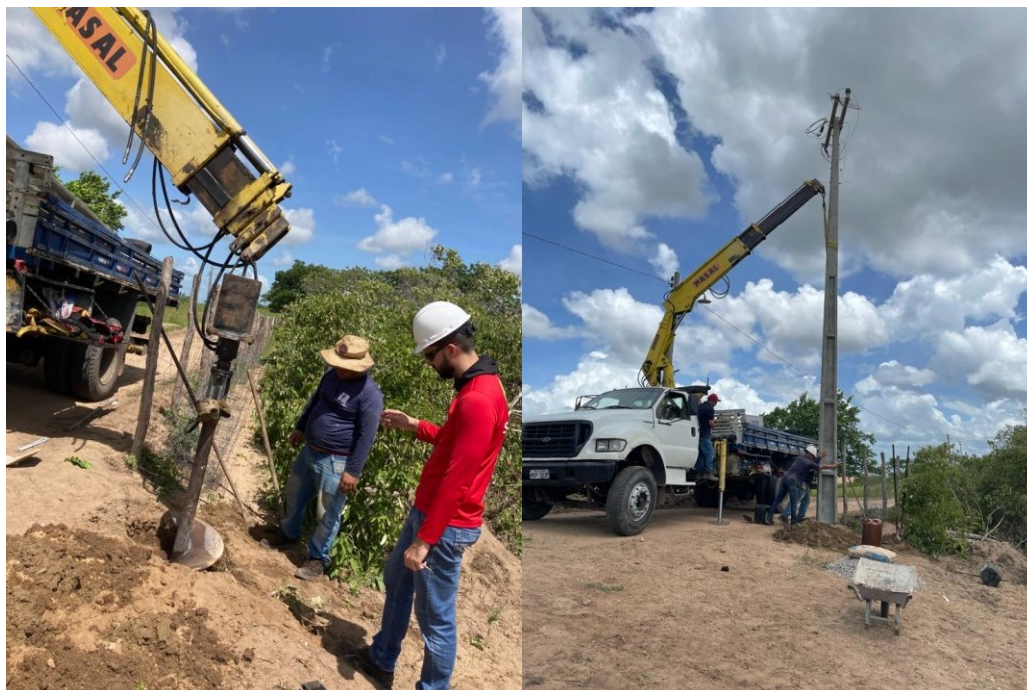
Figura 26: Montagem Subestação 75 KVA.
