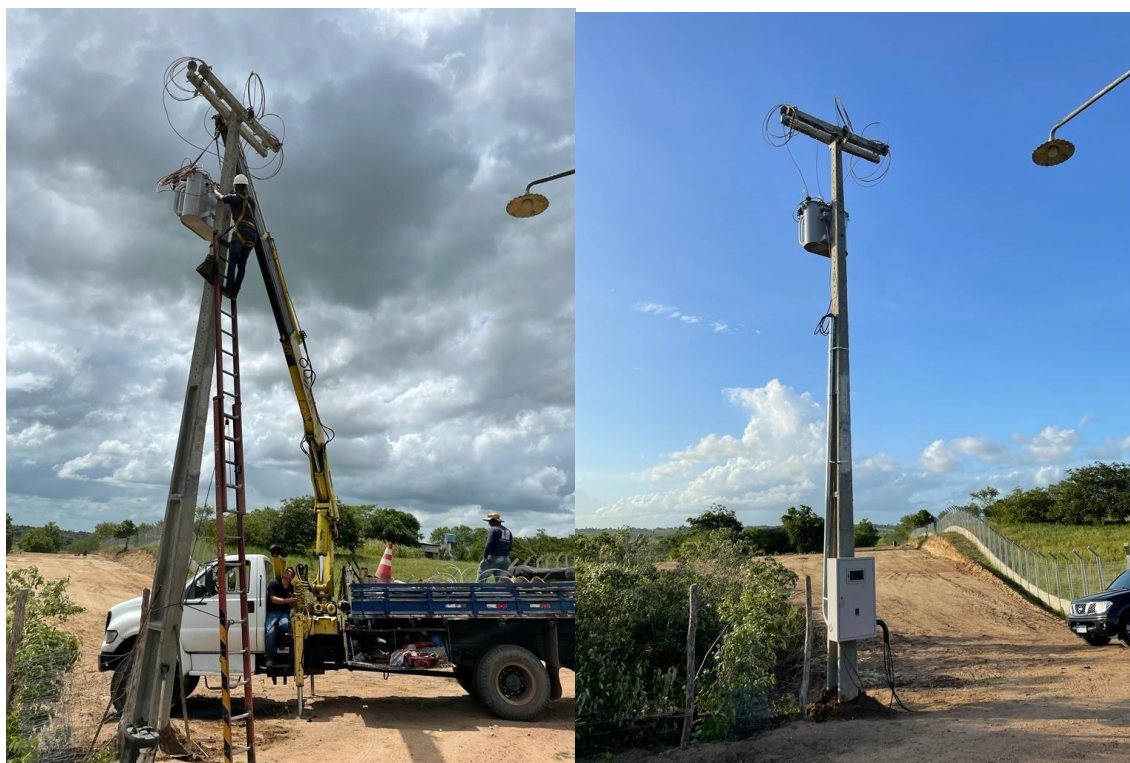
Figura 27: Montagem Subestação 75 KVA.
