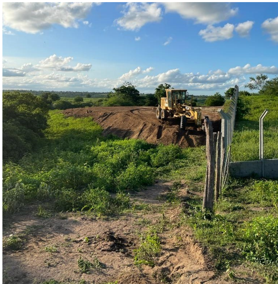
Figura 23: Processo de Terraplanagem da Área Escolhida.
