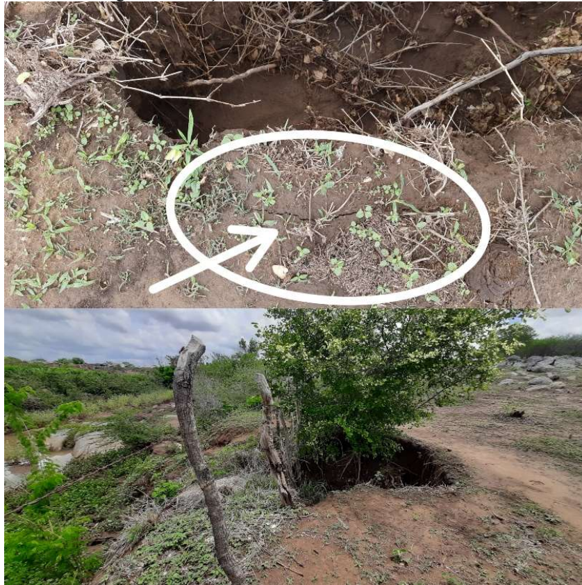
Imagem 14 - Voçoroca nas margens do Riacho Riachão.
