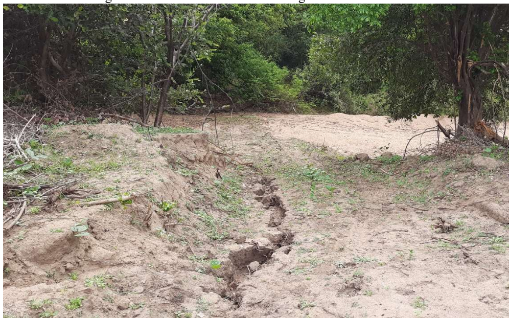
Imagem 12 - Erosão em sulcos nas margens do Riacho Riachão.
