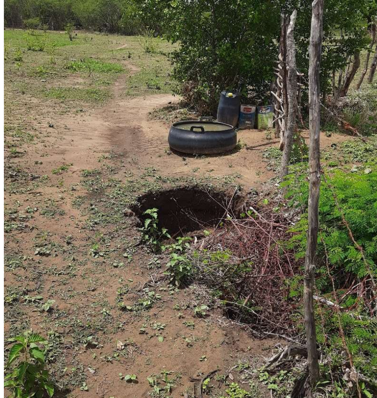
Imagem 13 – Voçoroca nas margens do Riacho Riachão.
