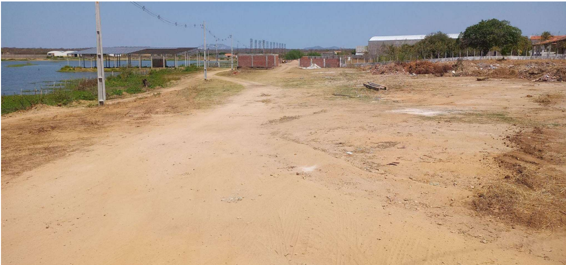
Figura 10 – Compactação do solo na área Oeste (a) e Leste (b) do açude ‘Boqueirão’.
