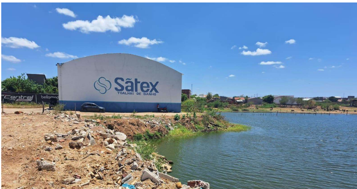
Figura 11 – Construções próximas ao açude ‘Boqueirão’ em São Bento – PB.
