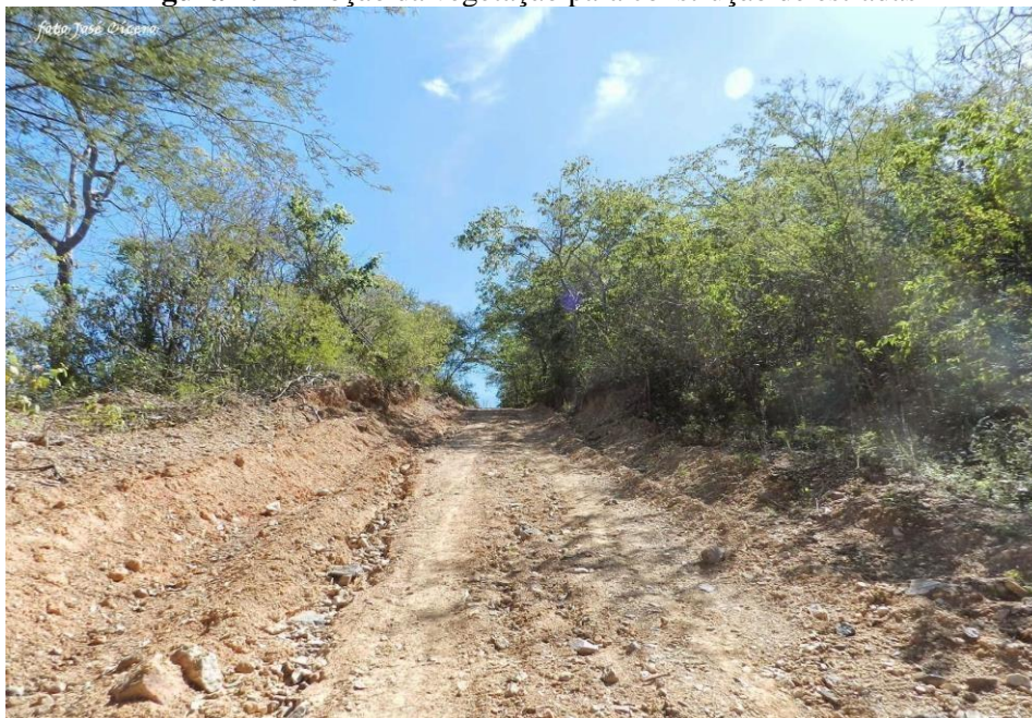
Figura 7: Remoção da vegetação para construção de estradas
