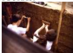
Aplicação do emboço interno
