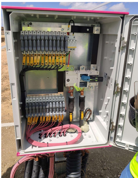
Figura 1 - Conexão das Strings na String Box
