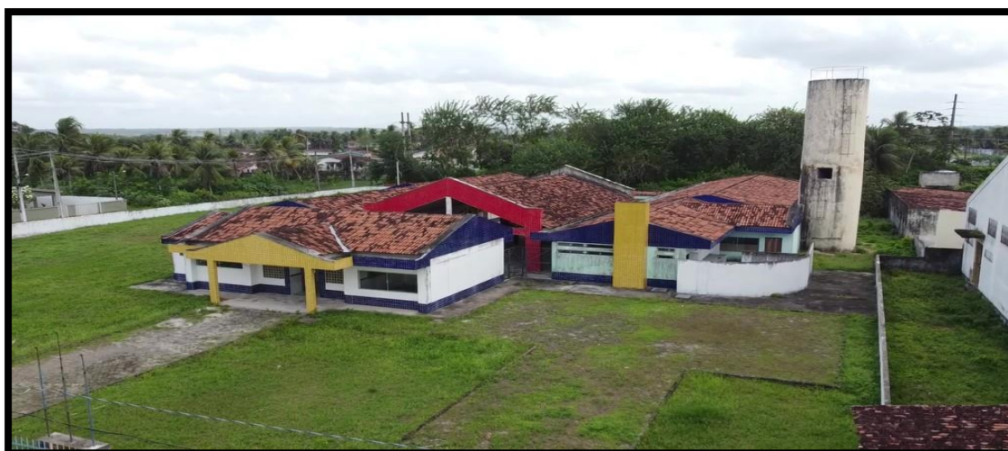
Rio Tinto (Mata Paraibana), Creche Tipo B, conveniada há 16 anos. Situação: com 100% de execução, não foi entregue a sociedade.
