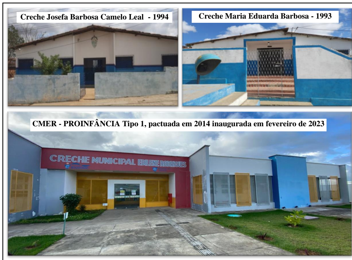
Figura 15 - Infraestrutura das creches do município de Boqueirão - PB antes e depois do Proinfância
