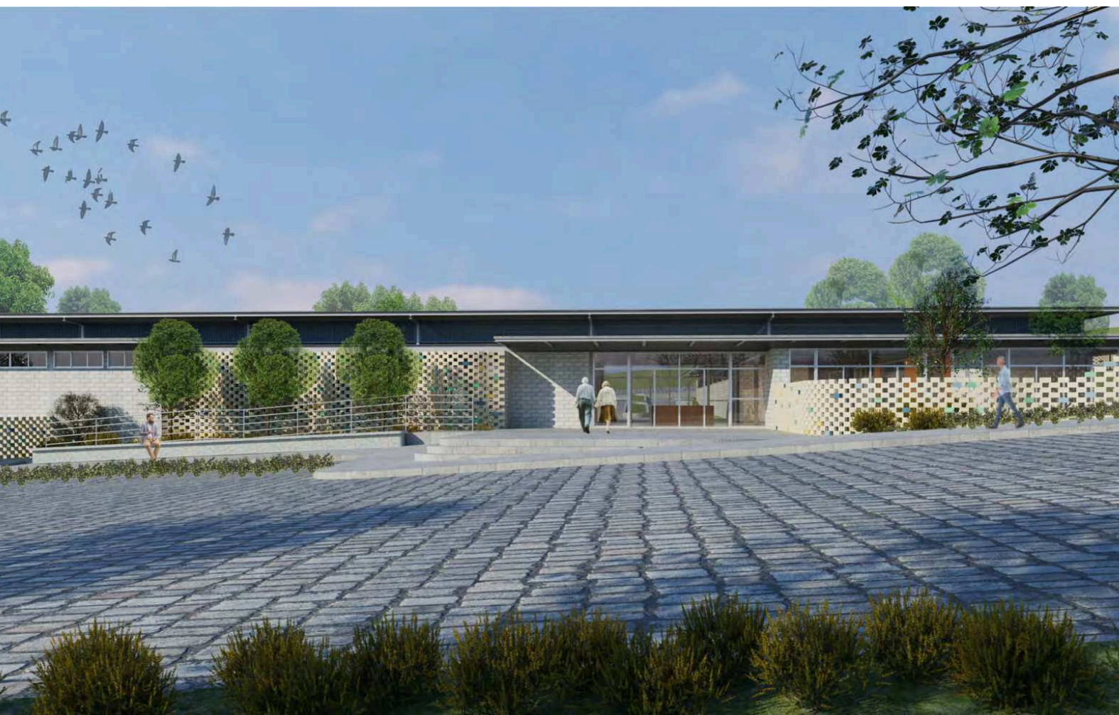
Figura 40 - Demarcação do acesso, fachada nordeste. Fonte: Elaborada pela autora, 2024.
