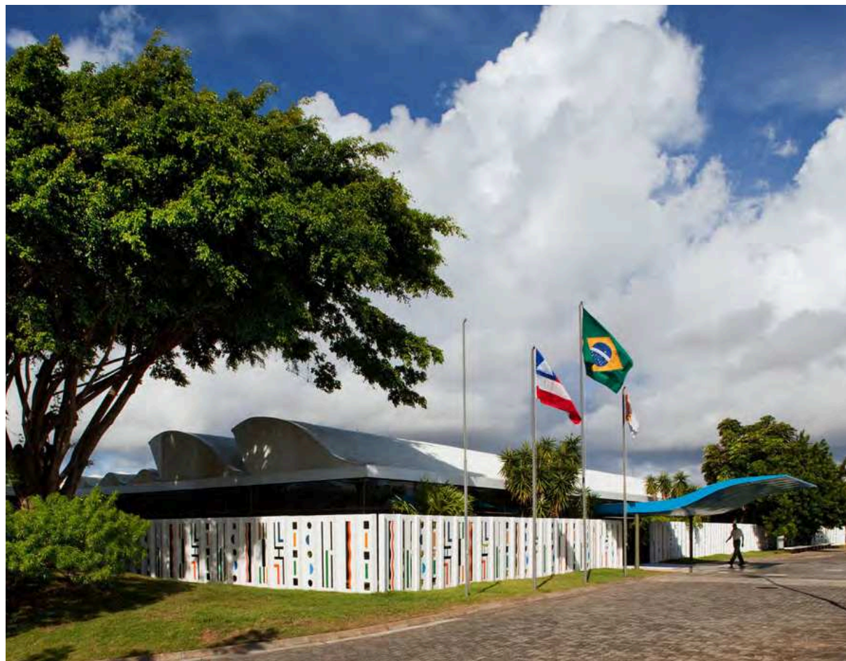
Figura 27 - Painéis artísticos na fachada principal. Fonte: Kon, 2012.
