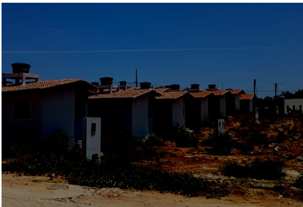
Figura 4 - Construção das novas casas populares no conjunto habitacional.
