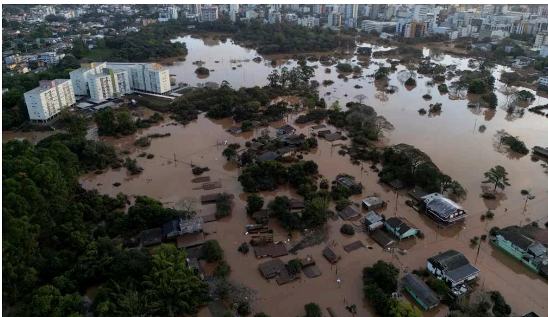
Figura 3: Casas submersas em Lajeado - RS
