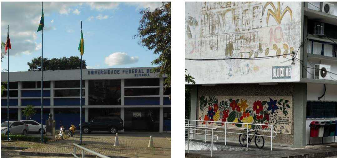
Figura 16 - Fachada do bloco AA (Reitoria) e bloco AB
