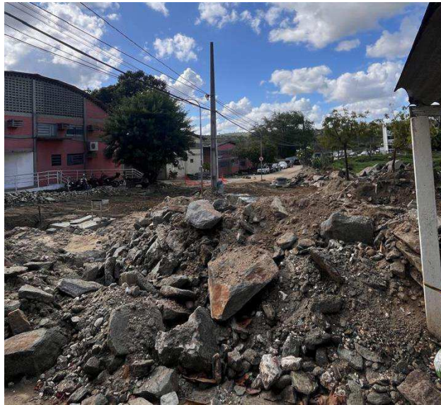
Figura 19 - Execução de obras na área
