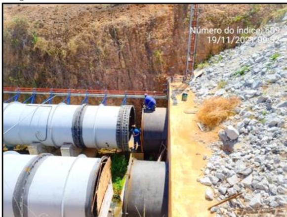
**Figura 21**-Instalação de nova válvula dispersora
