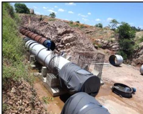
C- Revestimento das tubulações para concretagem e reconstrução da parede.
