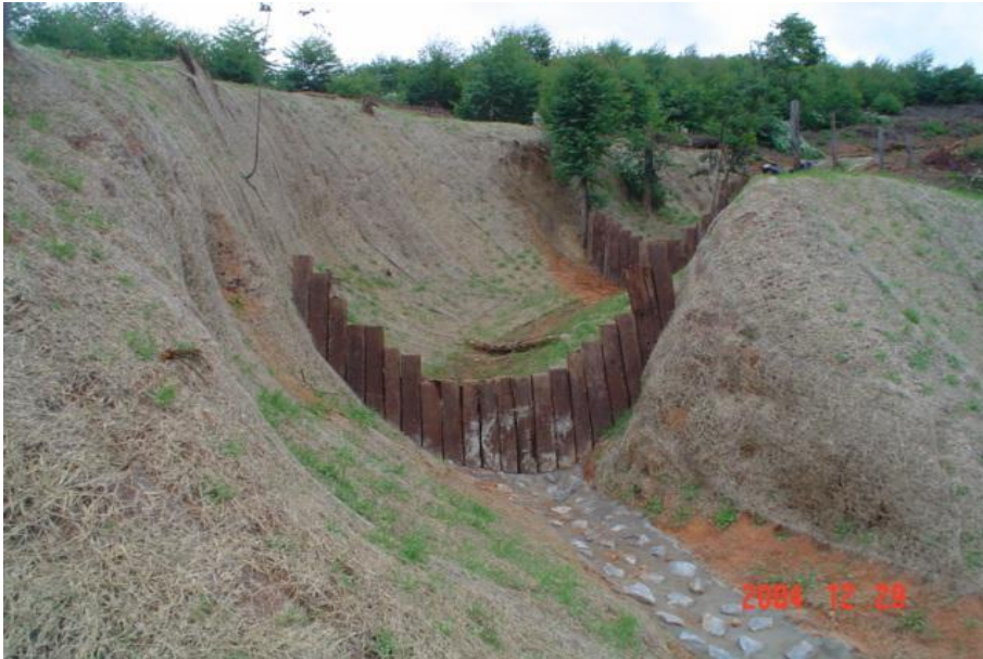
Imagem 5: dique de madeira
