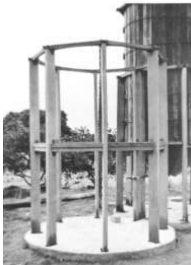
FIGURA 6.4 - Fixação das colunas nos anéis de madeira e na base
