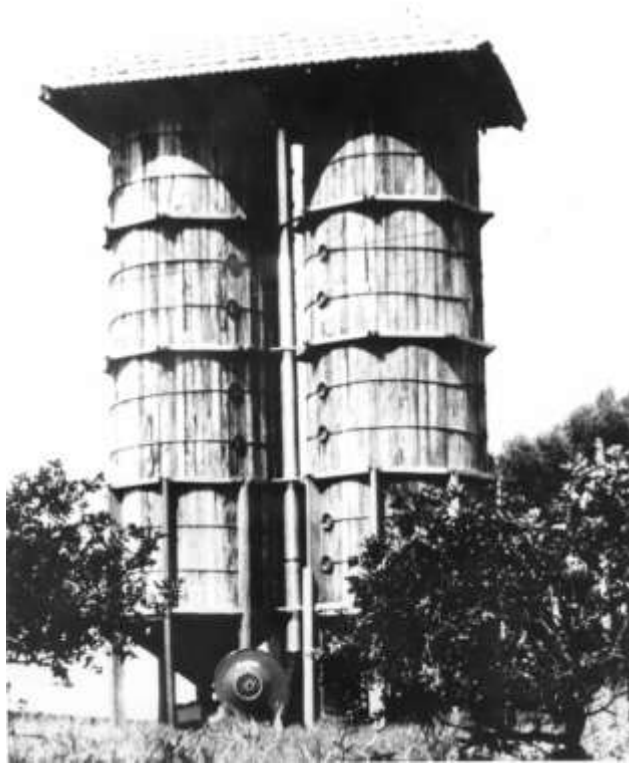
FIGURA 6.2 - Vista geral dos silos
