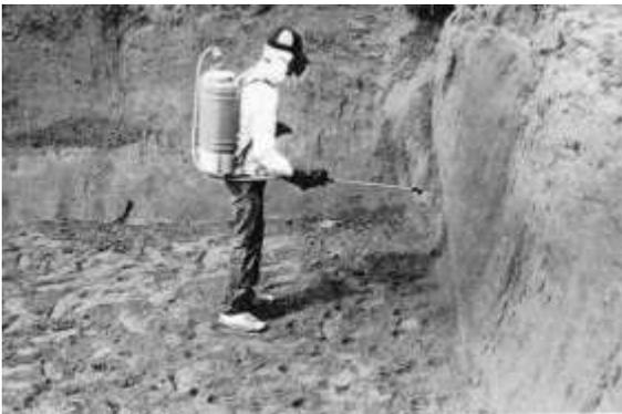
Figura 14 - Aplicação de cupinicida nas paredes e fundo da vala.
