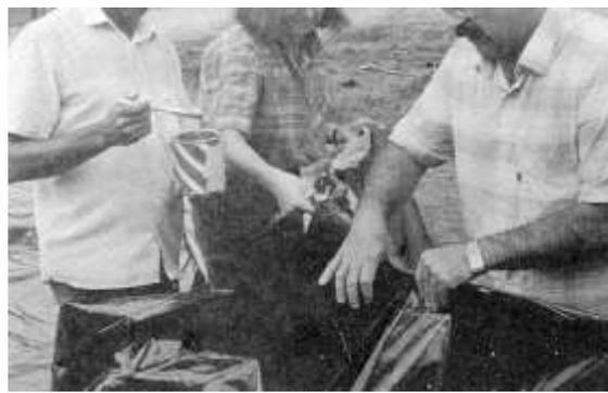
Figura 18 - Juntar os bordos pressionando-os e esticando-os para evitar o enrugamento da lona.
