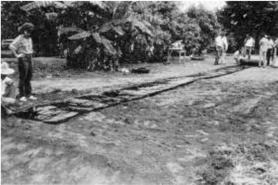
Figura 16 - Medição, corte e colagem da lona de envolvimento.
