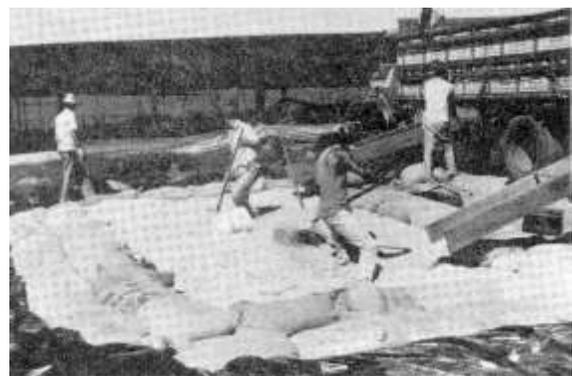
Figura 26 - Colocação de outra fileira de sacos sobre o produto a granel ao lado do primeiro quadro, formando o segundo quadro. Preencher e nivelar com o produto a granel até o nível do 2º quadro
