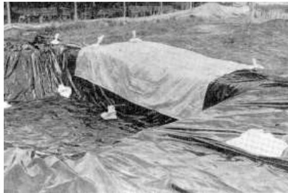
Figura 20 - Colocação do encerado ao lado da vala por onde será realizado o enchimento do silo.
