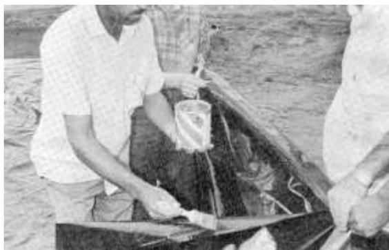
Figura 17 - Aplicação da cola em camada fina, nos dois bordos da lona, para melhor aderência.
