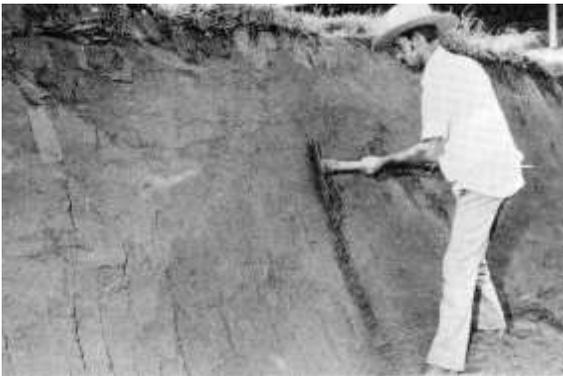
Figura 13 - Homem fazendo a inclinação das paredes do silo.
