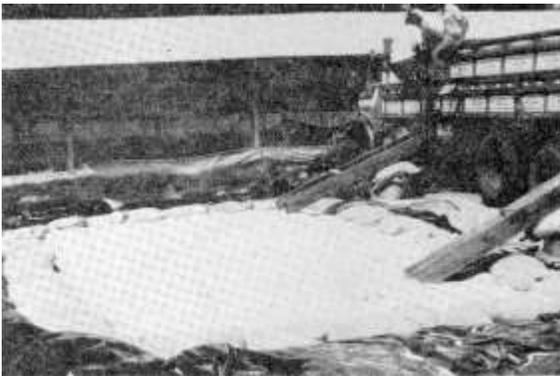
Figura 25 - Colocação do produto ensacado em fileira ao redor do perímetro da vala sobre o produto a granel, até o fechamento da *pirâmide*.
