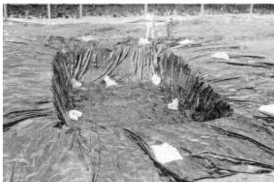
Figura 19 - Centralização e fixação da lona plástica.
