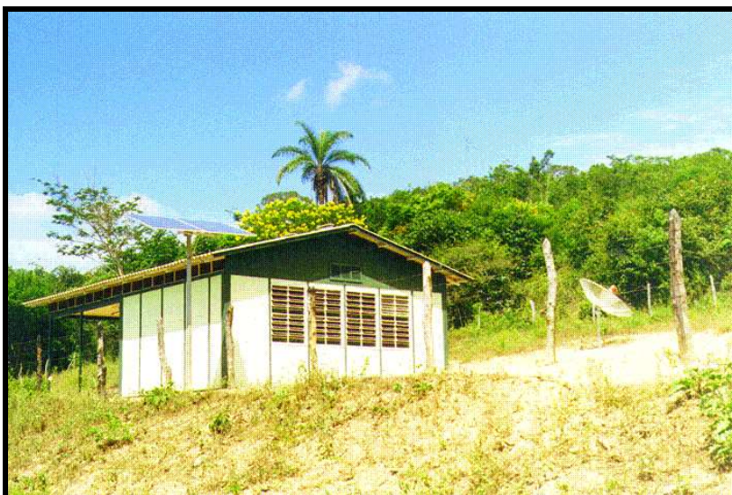
Foto 1 - Painéis fotovoltaicos e antena parabólica na escola pública de Diamantina (MG)
