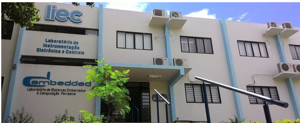
Figura 1 – Fachada do Prédio Gurdip Singh Deep.
