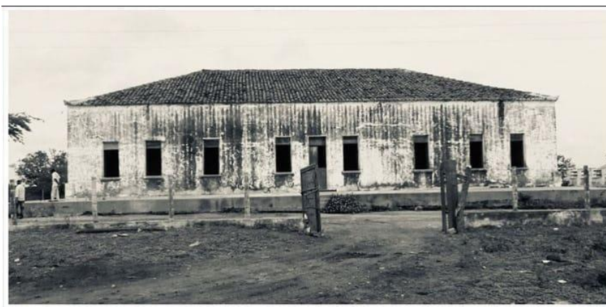
Figura 1 - Fazenda Nova Acauan antes da reforma
