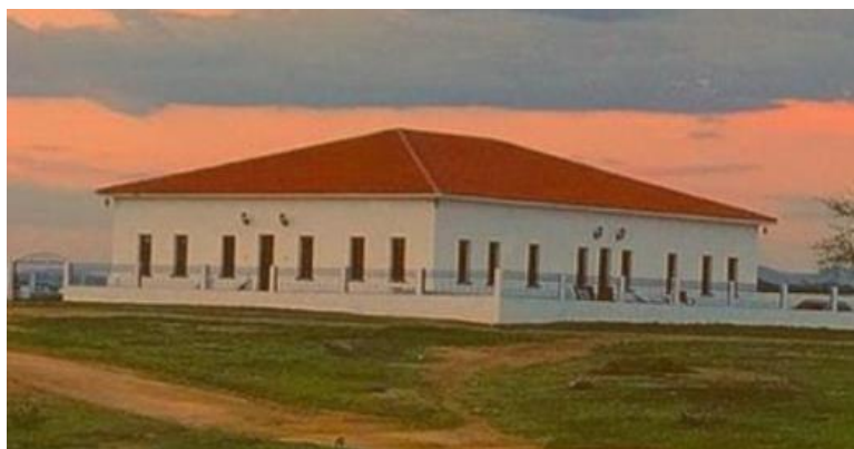
Figura 6 - Fazenda Nova Acauan após a reforma em 2015
