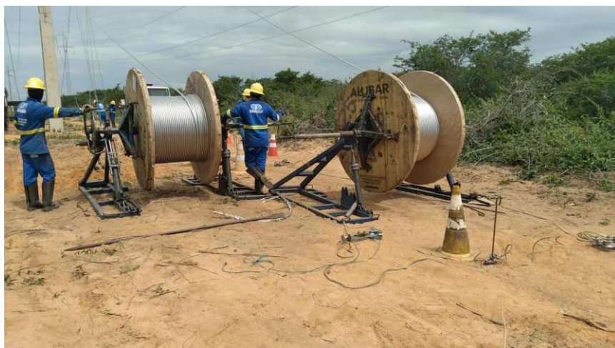
Figura 10: Lançamento de cabos condutores
