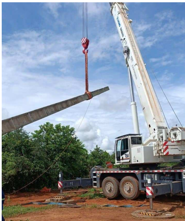
Figura 8: Atividade de implantação com guindaste.
