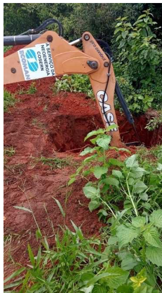
Figura 6: Acompanhamento da escavação
