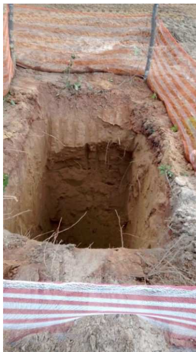
Figura 7: Escavação sinalizada com cerquite
