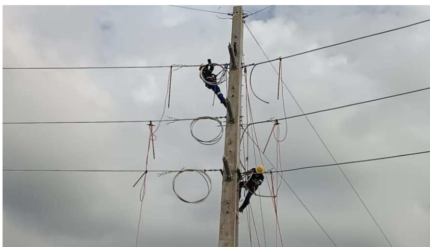
Figura 11: Fechamento de pulo de uma estrutura RA-MV-PR
