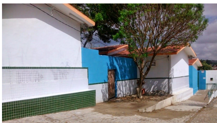
Figura 4 - Parte interna da Escola
